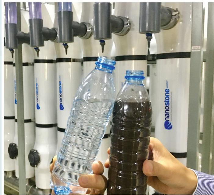
▲ 某废水回用项目中的纳诺斯通陶瓷超滤膜装置
